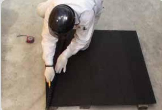
STEP 02 目地プレートの取付け穴を φ9mm のドリルで開ける。
