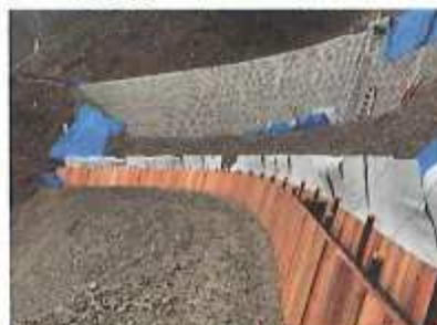
(現場で組立て設置)
