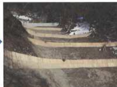
(コンクリート打設)
